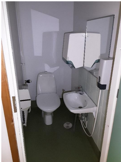
Kuvat 35. ja 36. WC pytyt
