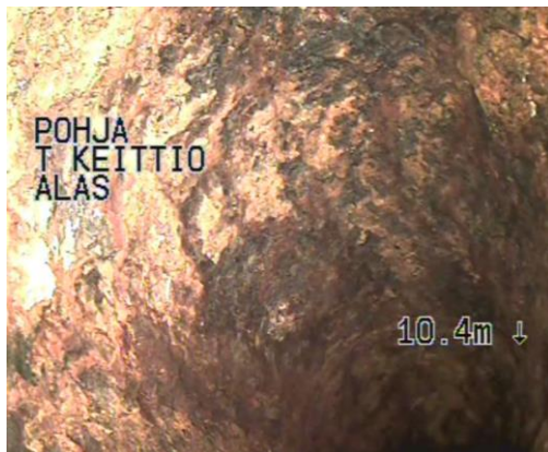
Kuva 11. Rasvaviemäri, välissä valurautaviemäriä, joka hilseilee.
