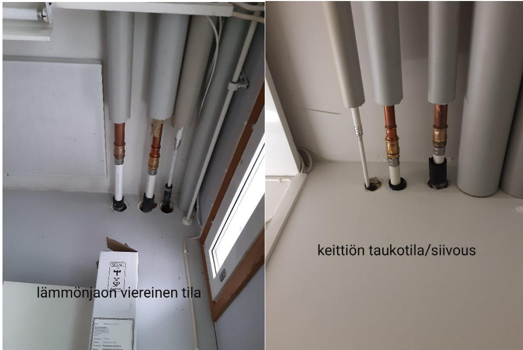
Kuva 10. LVK-vesijohto supistettu tilojen 163-161 välillä.
